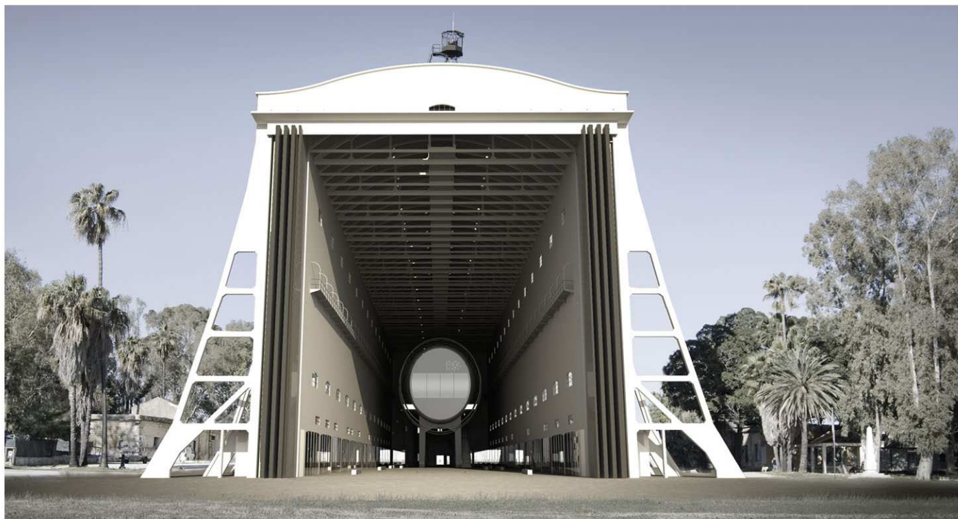
IL PROSPETTO PRINCIPALE CON IL PORTALE METALLICO APERTO
