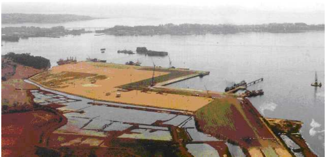
Stato di avanzamento dei lavori del secondo lotto del porto commerciale di Augusta (2004)
