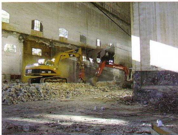
Demolizione delle costruzioni interne non previste nel progetto originario
