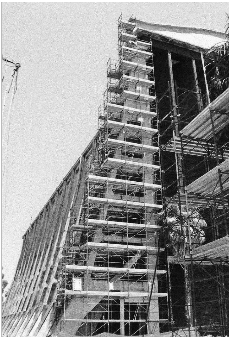
I lavori di consolidamento del 2009.
