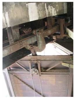
E' da sottolineare che tutte le giunzioni di questa enorme struttura metallica sono state realizzate mediante bulloni e perni rivettati. Le ante del portale, in condizioni di efficiente funzionamento, erano sospese ad una trave metallica e vi scorrevano mediante **carrelli.** Il
