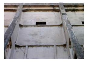
costituendone l'ossatura, in questo edificio è tutta esterna; una soluzione architettonica, questa, suggerita da motivi tecnici visto che l'edificio, destinato al ricovero di dirigibili, necessitava di molto spazio e poco ingombro. I tamponamenti sono ancorati solo parzialmente al sistema di travi e piedritti, e ciò al fine di limitare i danni in caso di un'eventuale esplosione dovuta alla presenza di idrogeno, altamente infiammabile, che
