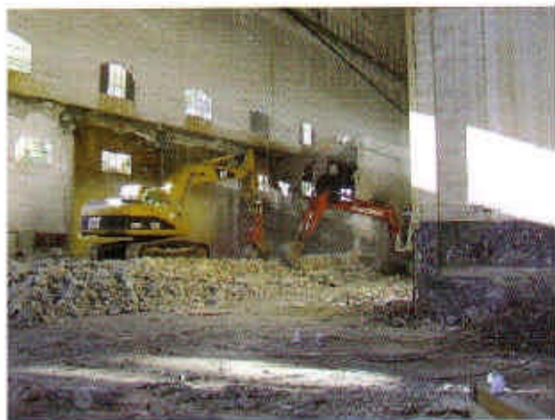
Demolizione della costruzioni interne non previste nel progetto originario
