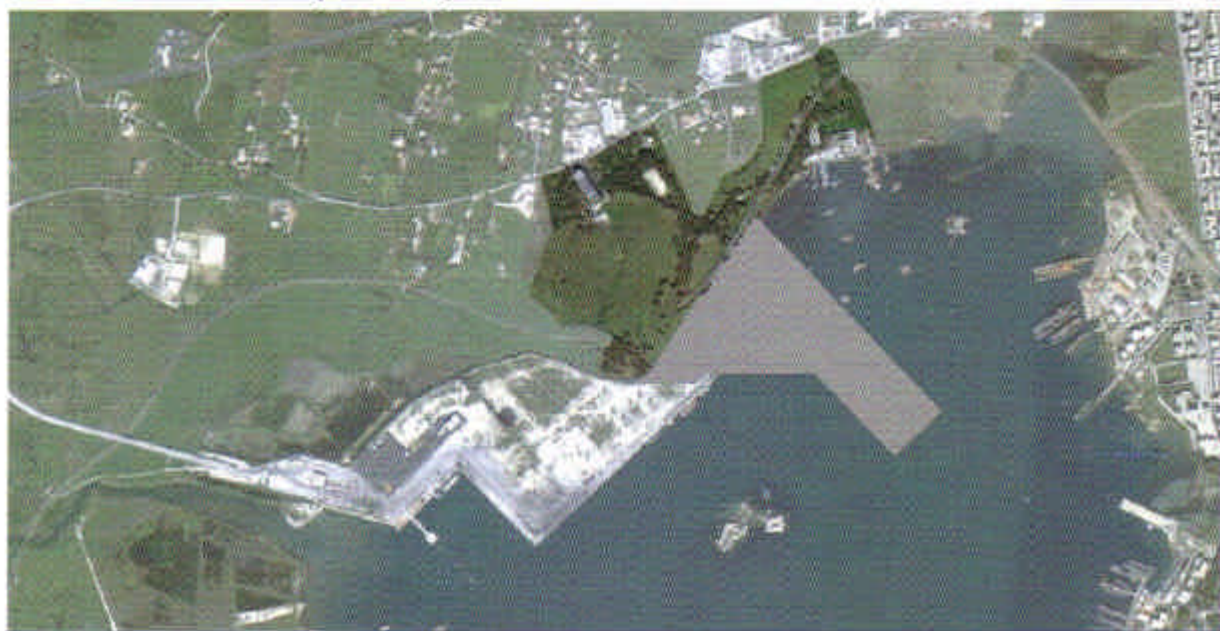
Vista satellitare del Parco dell'Hangar della banchina del porto commerciale già realizzata e simulazione dell'ampliamento previsto del progetto ASI
